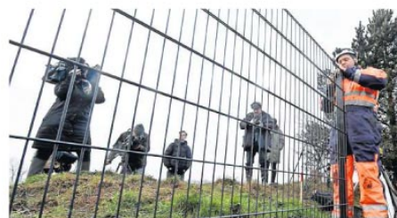
Arbeiter montieren ein Zaunelement.
